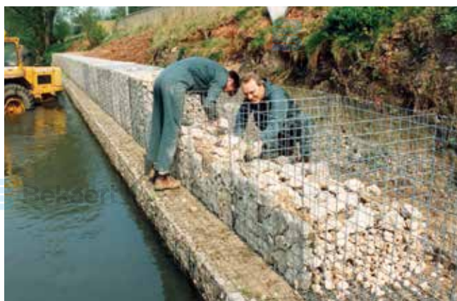
工匠精神打造精品工程
