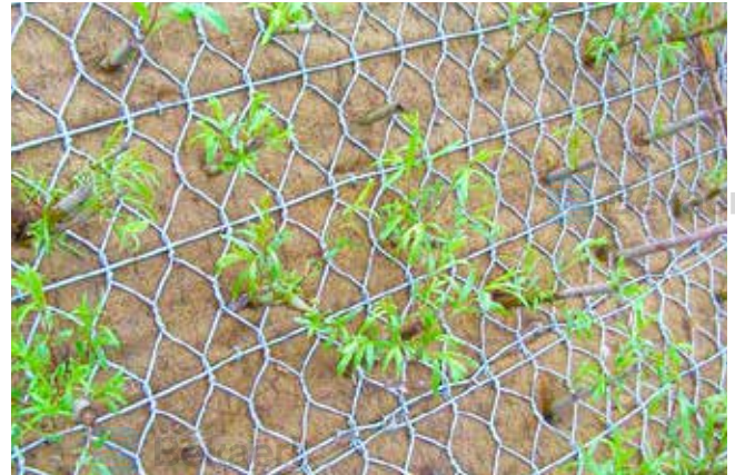
加筋面板可配合植生产品实现复绿
