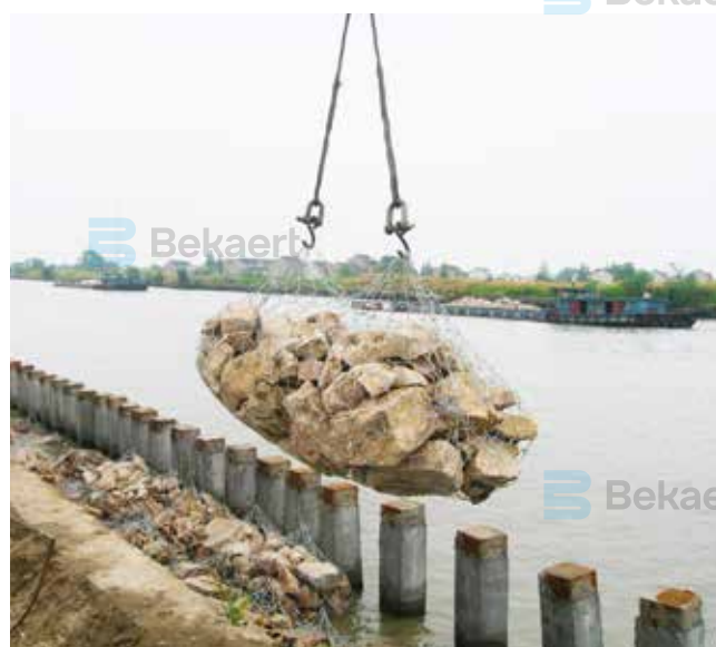
网兜吊放施工
