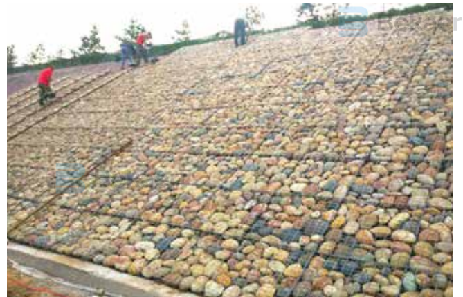
配合无锈熔接网面板，可提高美观性
