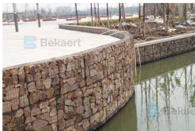
材料的特性可以保障结构曲线的布置需求
