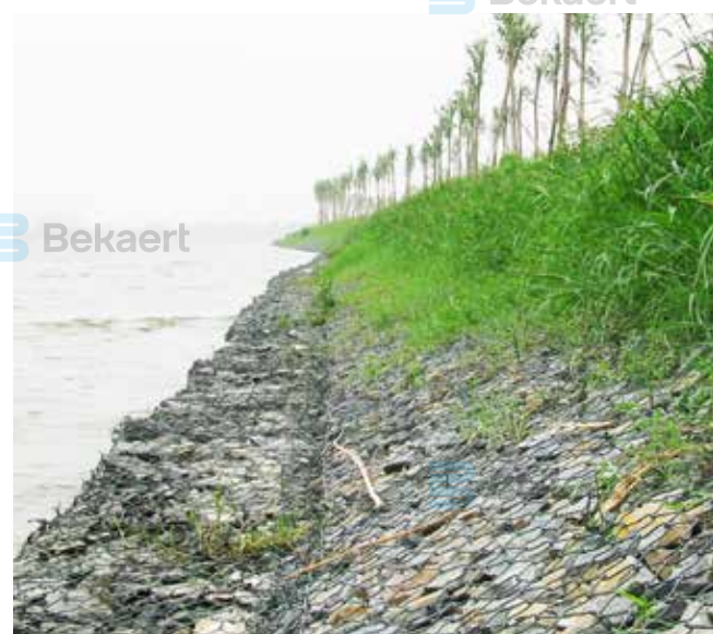
城市内湖堤坡防护
